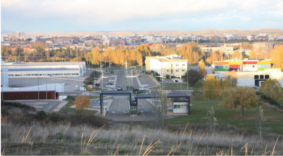
Ilustración 35. Imagen del eje central del PTL y puerta de enlace con la ampliación
